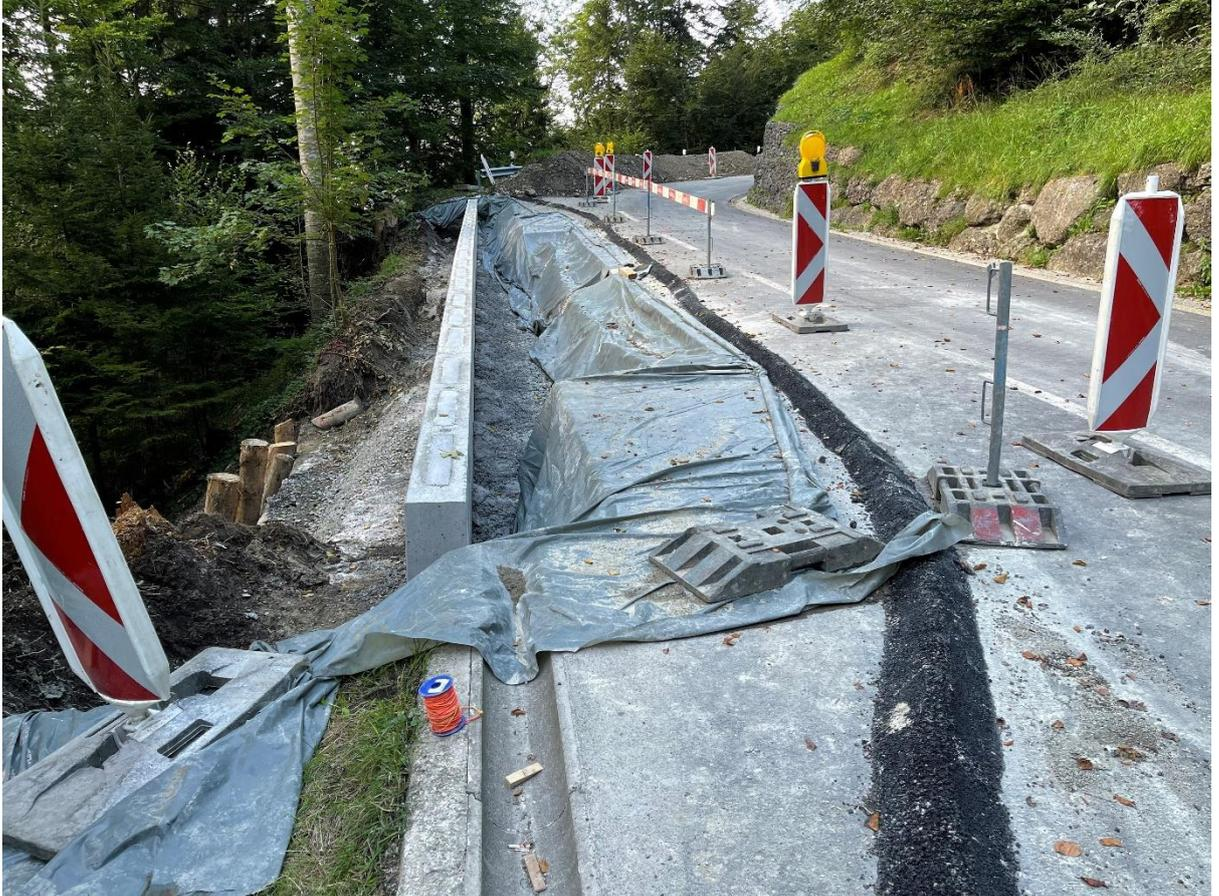
Die Reparaturarbeiten an der Cholrainstrasse schreiten zügig voran. Der Hang ist stabilisiert und kommende Woche wird der Belag eingebaut. Danach wird die Strasse wieder dem Verkehr übergeben.
