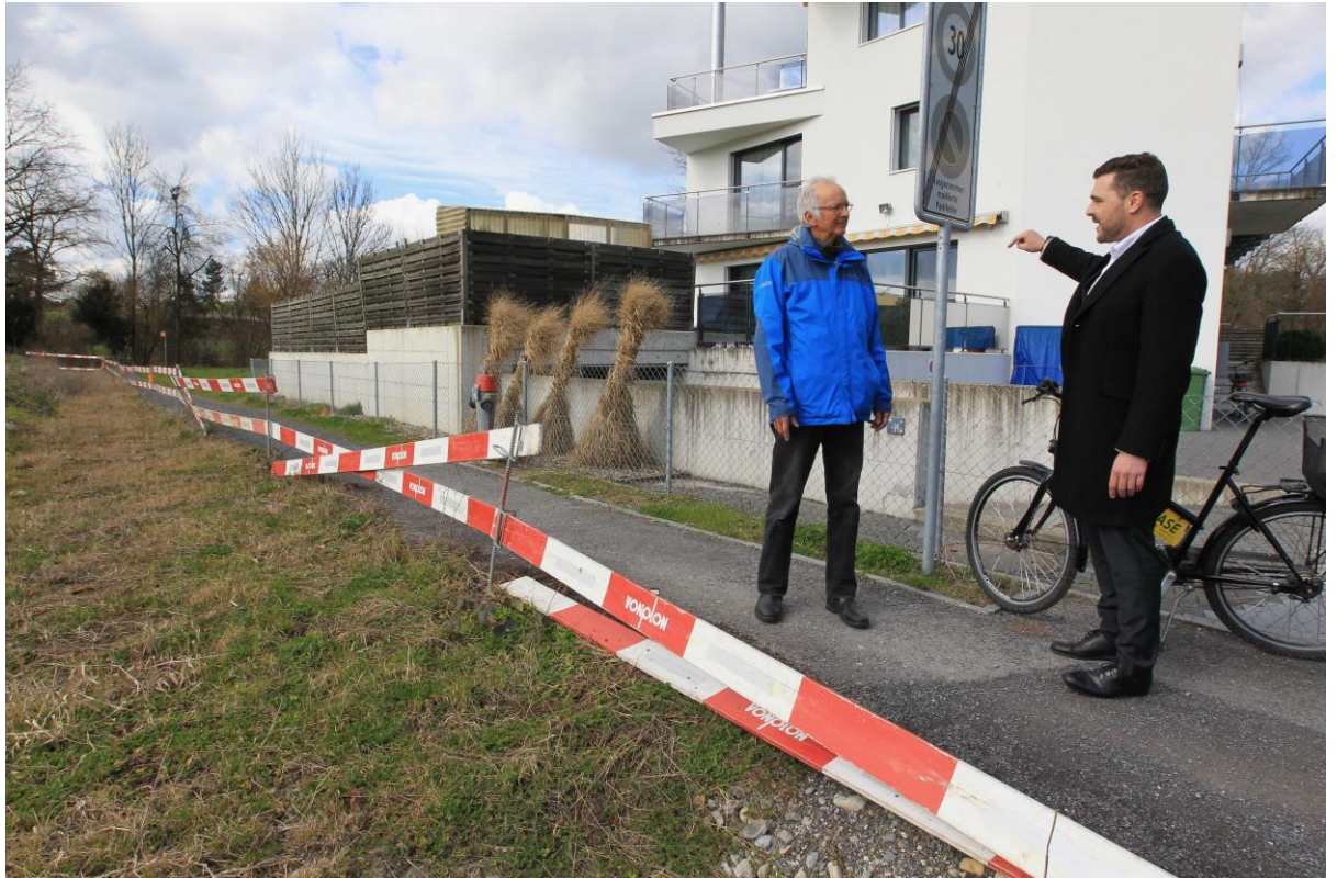
Baudirektor Florian Weber (rechts) erläutert Erwin Bestgen, wie das Teilstück des Lorzenuferwegs ausgebaut wird.
