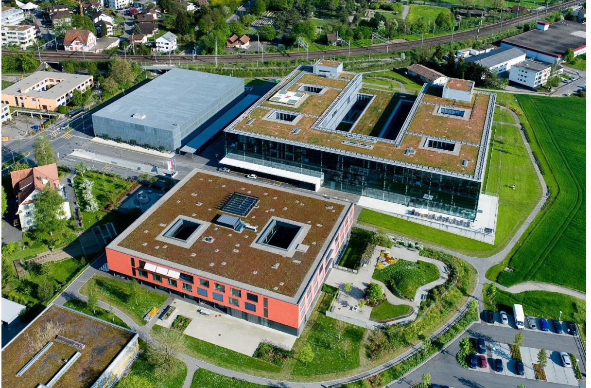
Die Nordfassade des Zuger Kantonsspitals (oben) wird ab diesem Juli in Stand gesetzt.
