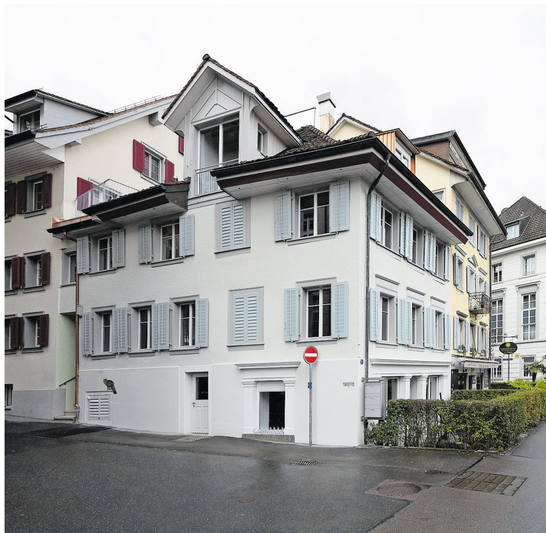
Äusserlich hat sich am Haus an der Seestrasse 1 in Zug wenig verändert. Der Umbau zu einem Einfamilienhaus gestaltete sich aber anspruchsvoll.
