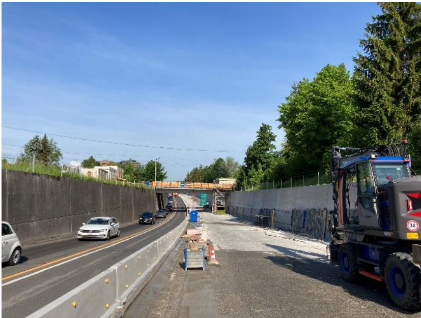
Die SBB Brücke über der Grundwasserwanne in der Kollermühle wird um 50 Zentimeter angehoben.
