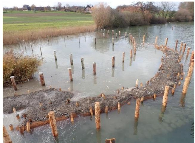
Foto 50, 51: Nach der Einfassung des Riffs mit Kokosnetzen wurde alles mit einer Schicht Kies überschüttet. Das Kies wurde aber innert kurzer Zeit von den Wellen wegerodiert. Bemerke auf dem rechten Bild an der linken Bildseite das im Jahr zuvor geschüttete und bewachsene Riff.
