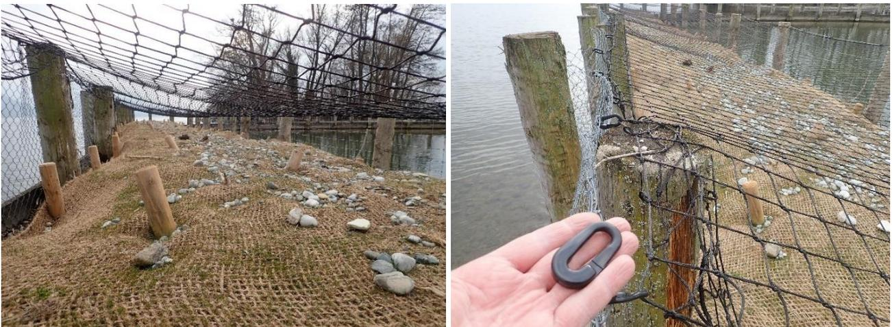
Foto 54, 55: Nahaufnahme des Nylonnetzes. Dieses konnte mit Klammern an den seitlichen Zaun montiert werden.
