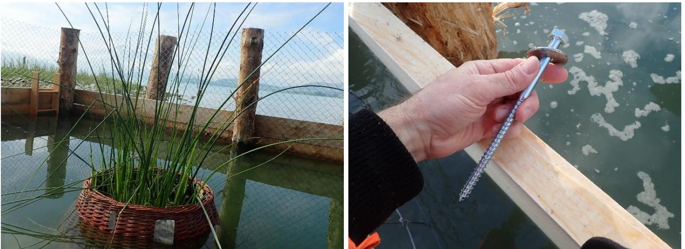
Foto 14 und 15: Im Hintergrund ist die Bretterwand ersichtlich, welche mit alternierenden Holzstämmen beidseits verankert wurden. Foto rechts: Befestigungsmaterial.
