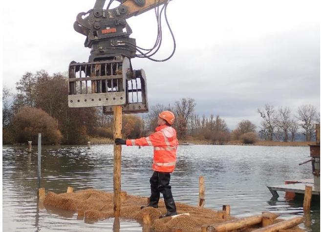
Foto 46, 47: Bau des Riffs bei Sijental 2019. Die Arbeiten erfolgten mittels eines Pontons und Bagger. Die Kokosnetze- und Faschinen wurden mit Holzpfählen befestigt.
