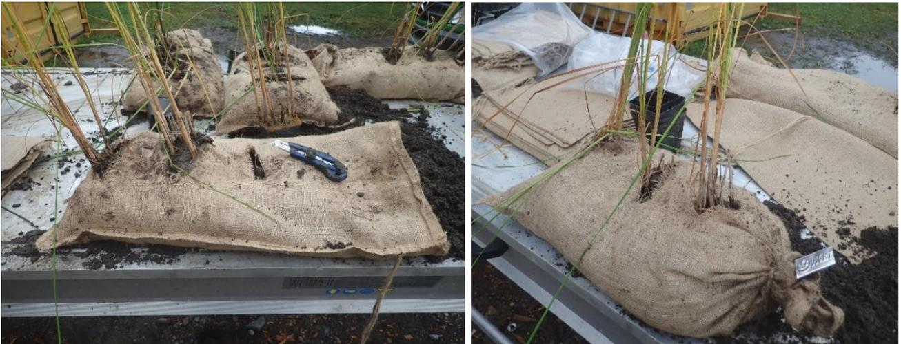
Foto 39 und 40: Herstellung von Unterwassersäcke.
