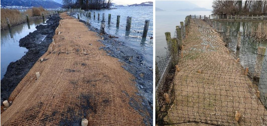
Foto 52, 53: Schilfrhizom-Schüttungen am Nordufer des Zugersees bei der Lorzenmündung, Winter 2021/2022 (links). Schüttung östlich der Aloisius Insel, Herbst 2022 (rechts). Dieses Riff wurde mit einem Nylonnetz gegen einfliegende Gänse geschützt.
