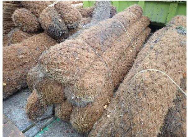
Foto 48, 49: Schilfrhizomhaltiges Verlandungsmaterial. Kokosfaschinen zu Dreiecksformen zusammengebunden, zur seitlichen Einfassung des Riffs.
