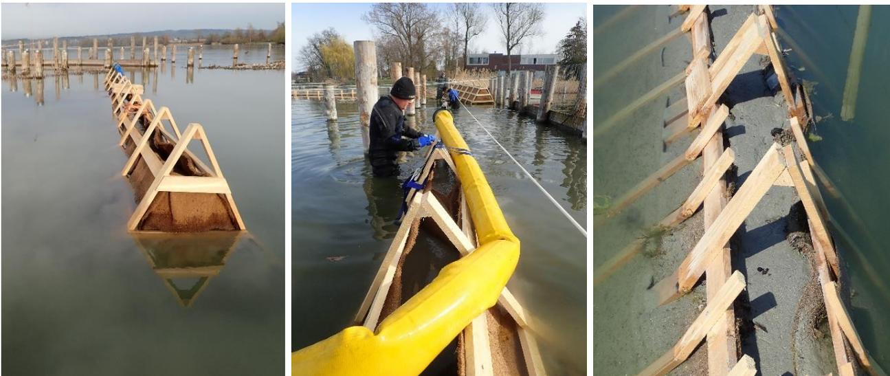
Foto 36-38: Dreieck-Holzelemente. Die leeren Teilelemente wurden am Ufer zusammengefügt und leer in den See platziert (links). Füllen der Elemente mit Seegrund mittels Pumpen (Mitte). Gefüllte Elemente (rechts)
