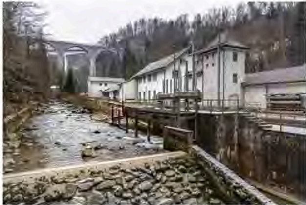
Abbildung 9: Schützenswerte Schalt- und Trafostation mit angebauter Halle (ganz rechts) und den Lorzebrücken im Hintergrund
