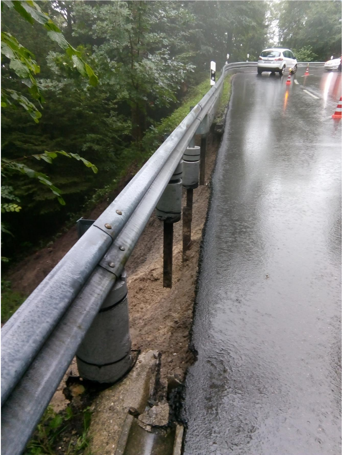
Teile des Banketts und des Kieskoffers der Cholrainstrasse sind beim Erdbeben vom 1. August 2021 in die Tiefe gerutscht.
