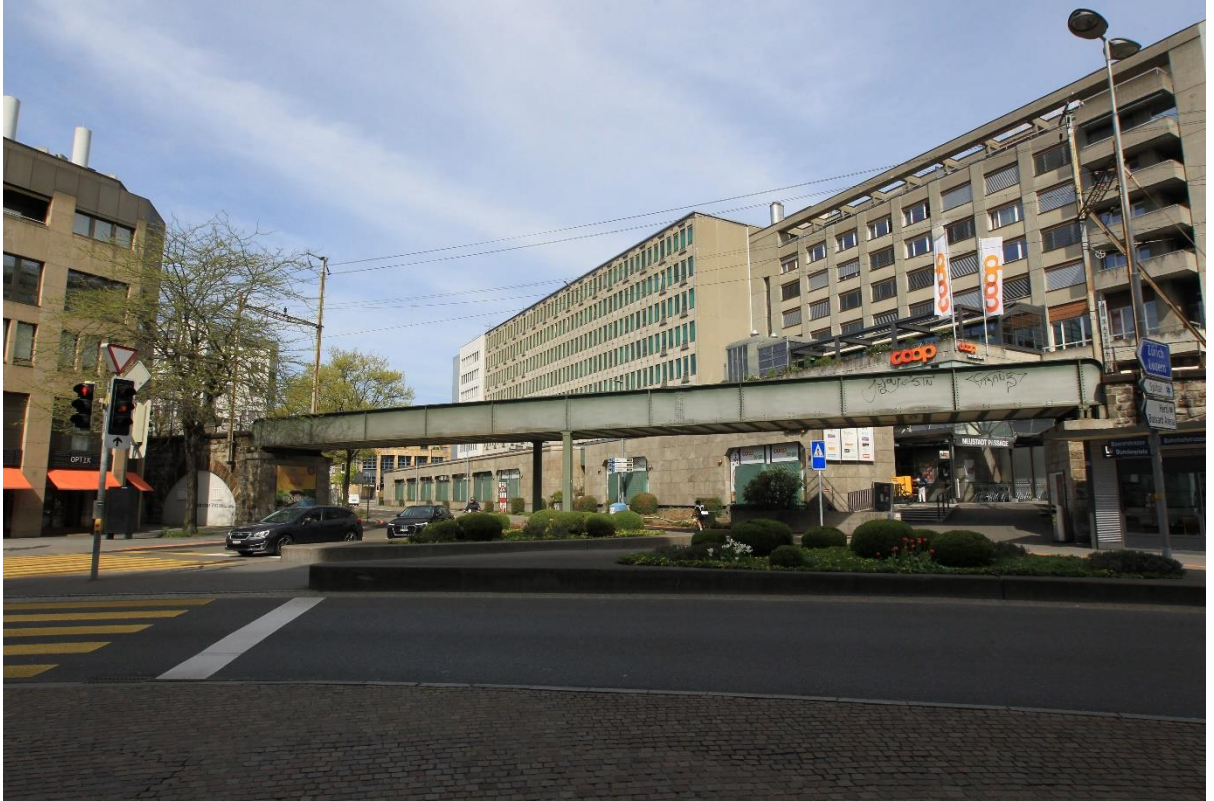
Die SBB-Brücke beim Bundesplatz in Zug wird in den kommenden Wochen saniert.
