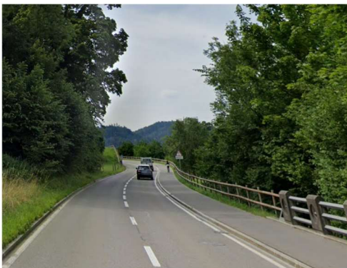
Abb. 20: typischer Strassenraum im Abschnitt F
