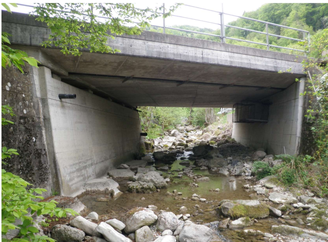
Abb. 40: Rufibachbrücke an der Kantonsgrenze Zug/Schwyz
