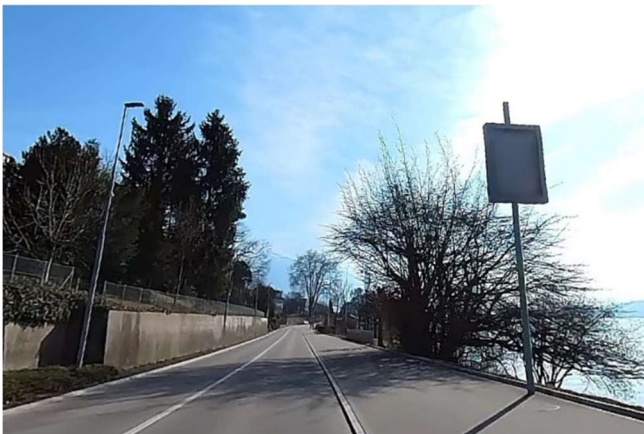
Abb. 13: typisches Bild für den Abschnitt B mit dem 3.50 bis 4.00 m breiten Fuss-/Radweg
