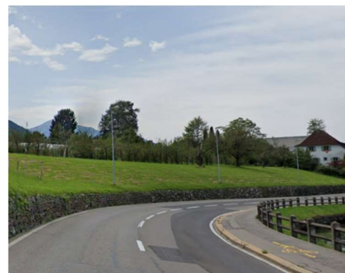
Abb. 15: typisches Bild für den Abschnitt C mit den hangseitigen Stützmauern (1828)
