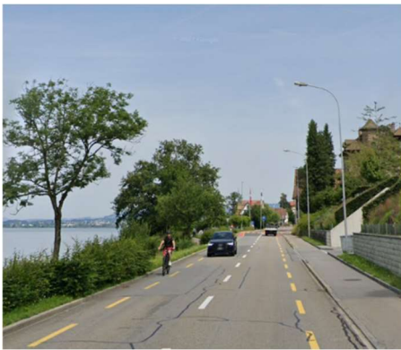
Abb. 18: typischer Strassenraum im Abschnitt E
