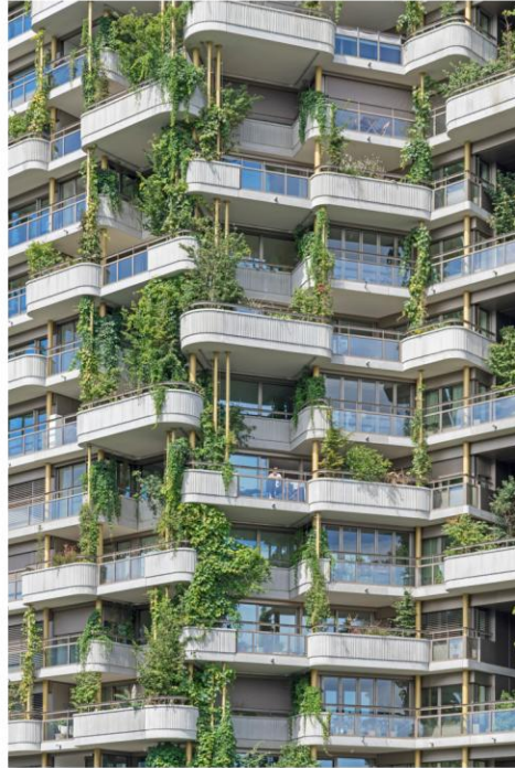
Gartenhochhaus Aglaya, Rotkreuz
