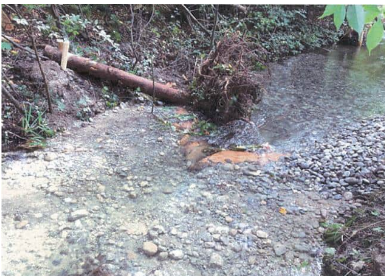
Abbildung 3.7: Beispiel einer V-Schwelle im Unterlauf der Alten Lorze
