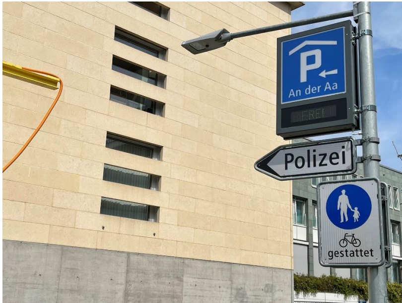
Das Parkhaus an der Aa wird ab Ende August 2021 saniert.
