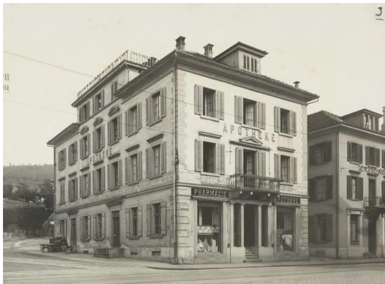
Abb. 3 Haus Neugasse 1, Ansicht von Nordwesten, Aufnahme um 1900 (Archiv ADA).
