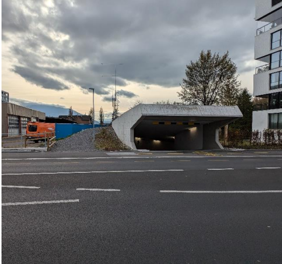
Unterbruch südlich der General-Guisan-Strasse (Bild von Norden, 18.11.2024)
