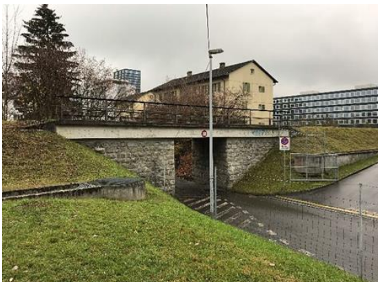
Brücke Weststrasse, Situation vor dem Abbruch
