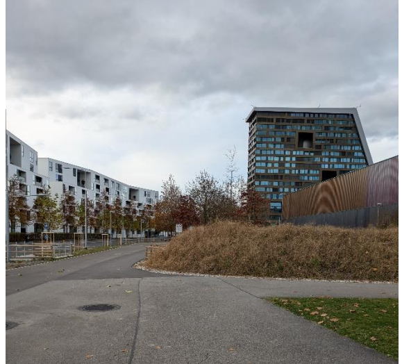
Unterbruch nördlich der General-Guisan-Strasse (Bild von Osten, 18.11.2024)
