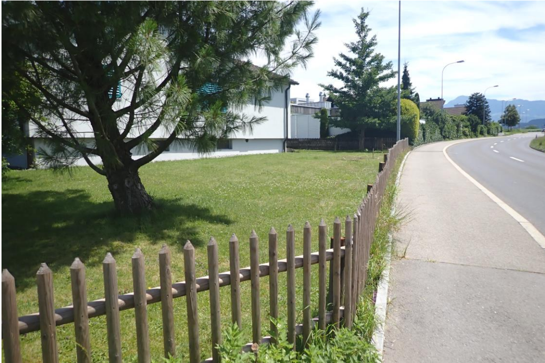
Holzhäuserstrasse in Hünenberg in Blickrichtung Holzhäusern.
