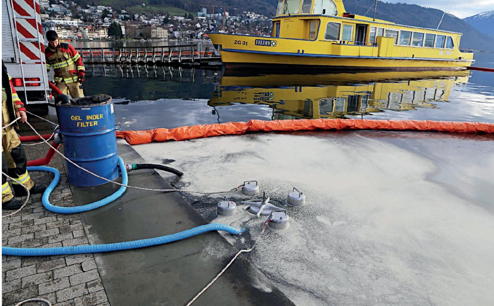
Abbildung 3: Das ausgelaufene Öl wurde innerhalb der errichteten Ölsperre mit Ölbinder gebunden und anschliessend abgesaugt. Auf dem Bild ist die «Yellow» erkennbar. Das Schiff ist heute nicht mehr auf dem Zugersee stationiert.
