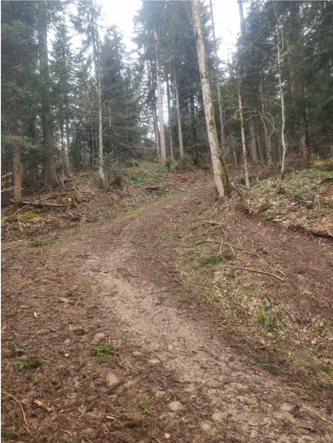
Abbildung 1 Schmierige Oberschicht des bestehenden Maschinenwegs im steilen Abschnitt
