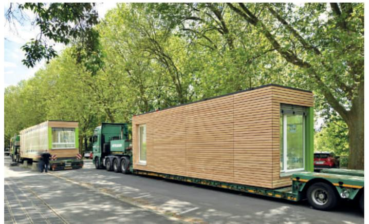
Abbildung 10: Raummodule aus Holz auf dem Tieflader
